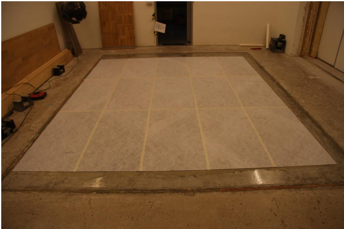
Bild 3 – Underläggens tejpade på ovansidan.
